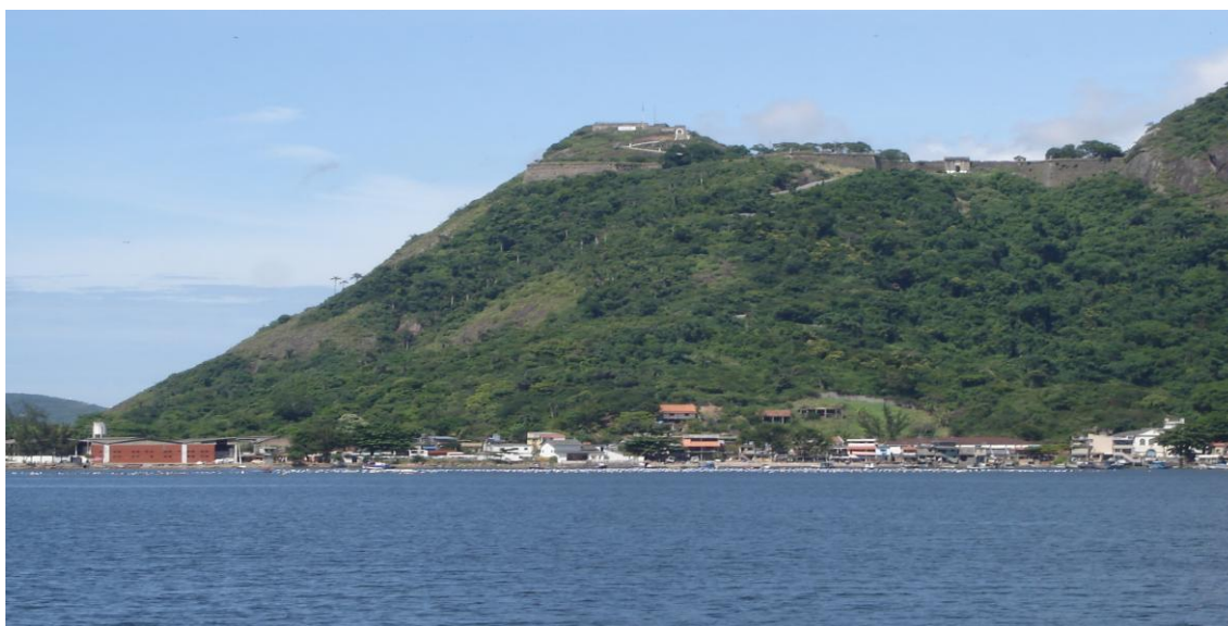
Figura 3.38 — Fábrica Atlantic Desativada (prédio vermelho) em Jurujuba – Niterói
