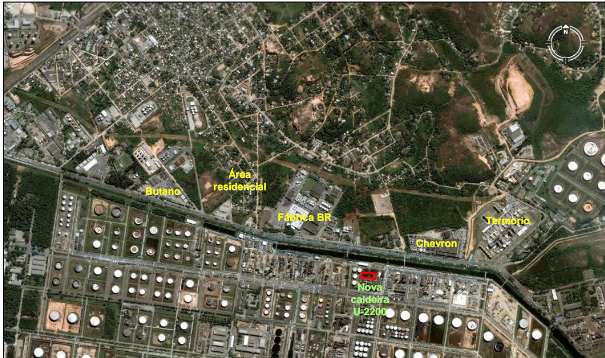
Figura 4.40 – Localização da Nova Caldeira da U-2200
