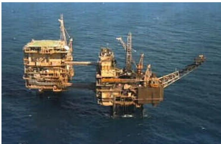
**Plataforma Satélite** trata-se de sistema composto de uma plataforma central com poços, processo e geração de energia associada a plataformas satélites, interligadas à plataforma central.
